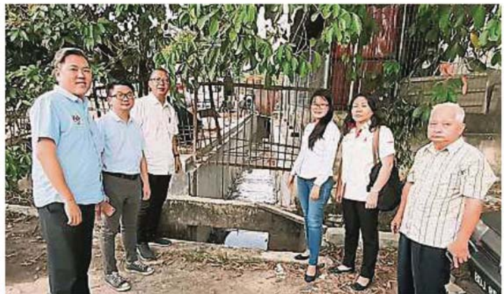
长年失修的防洪沟正在进行提升工程。左起为黄炳渝、丘钦瀚及神建华；右起为彭俊华、欧慧君及王诗棋。
